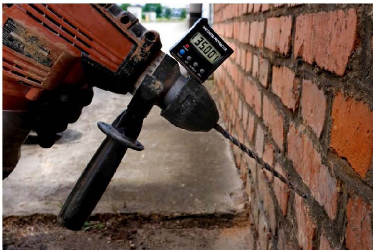
Obrázok 7: Rozstup otvorov a uhol 35°
