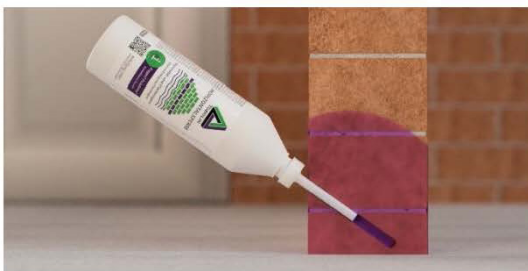
Obrázok 2: Metóda šikmého vŕtania
