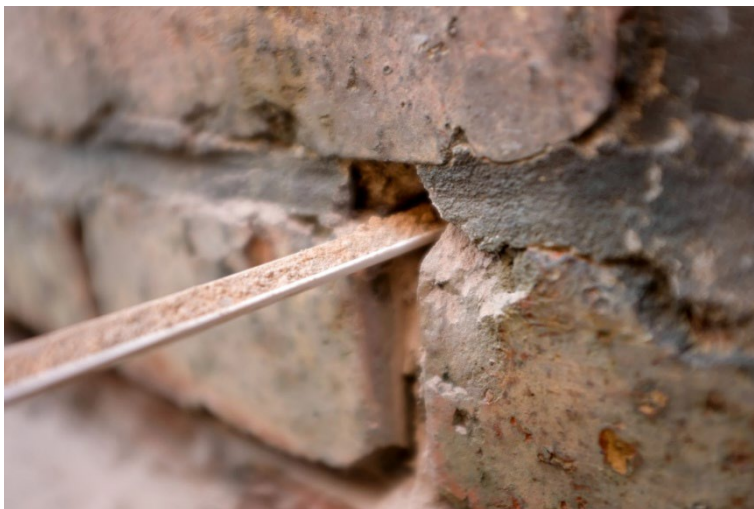
Obrázok 13: Čistenie vrtu plastovou polovičnou rúrou
