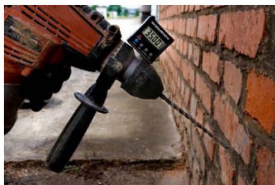
Obrázok 3: Vŕtanie metódou šikmého vŕtania
